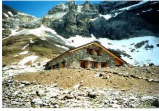
Le Refuge de Pierredar
